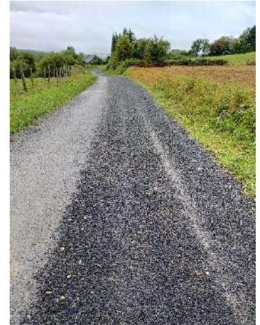
**Route de la Rivière** : travaux de renforcement avec terrassement poutre de rive, massif drainant, bloc d'enrochement et réalisation d'un revêtement tri couche : 5489,40 euros TTC.
