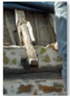
Maçonnerie à reprendre et à remplacer chaque coyau
