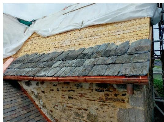
Opération couverture avec de grandes ardoises (type lauze) avec pose des gouttières
