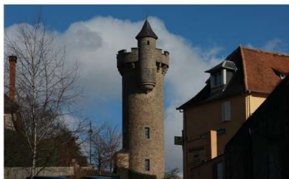
Château d'eau, commune de Masseret
