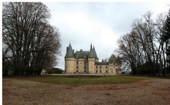
Château de la Grènerie, commune de Salon-la-Tour
